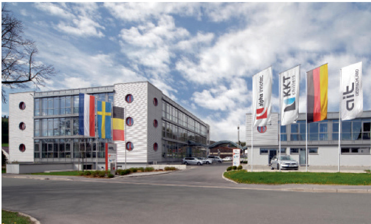
Sede alpha innotec em Kasendorf, Alemanha.
