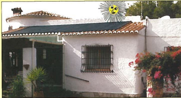
ROOS-Solar-Kollektor auf dem Vordach.
